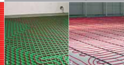
1 ▶ Instalación con panel aislante preformado
